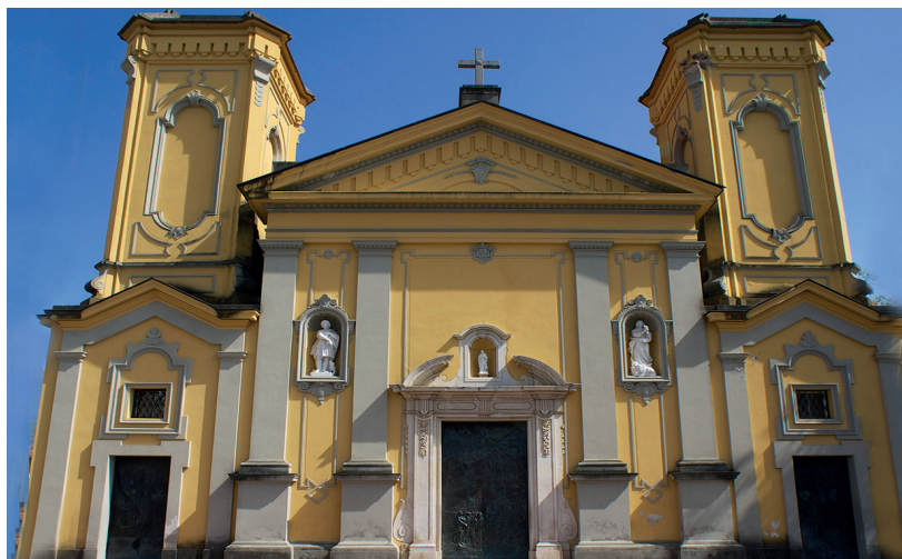
Facciata della Chiesa dell'Immacolata a Sapri.
